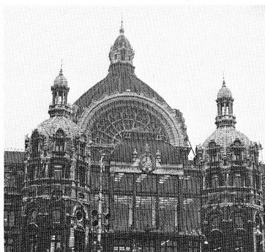
Façade de la gare d'Antwerpen. Édifiée à partir de 1895 sous la direction de l'architecte Louis De La Cenerie, la gare d'Antwerpen représente une réalisation très élaborée quant aux styles mis en œuvre et aux dimensions de l'édifice.
